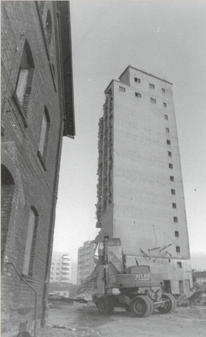
Ein Turm aus Beton und Stahl verschwindet langsam.
