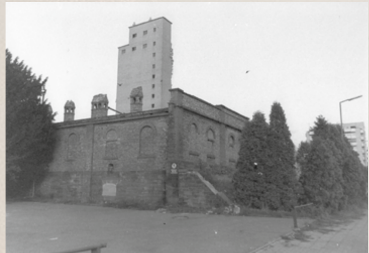
Der halbe Malzturm steht noch.
