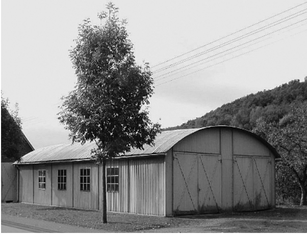
Bild 1-2 Dach und Wandbekleidung aus Wellprofilen
