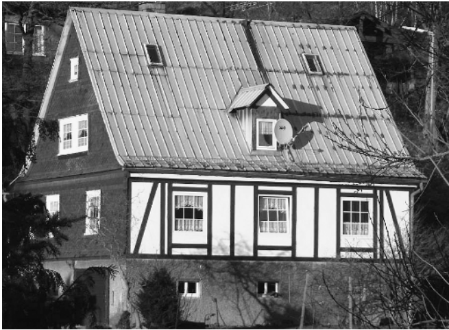
Bild 1-4 Dachdeckung mit „Siegener Stahldachpfanne“
