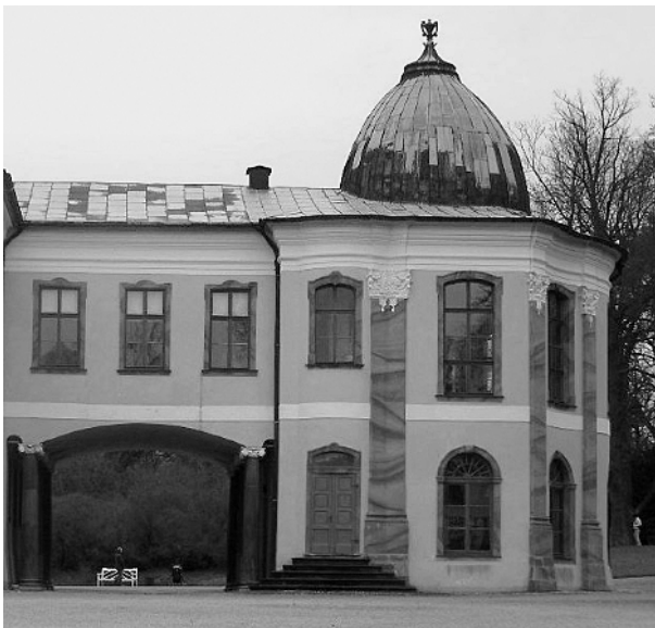
Bild 1-1 Handwerkliche Dachdeckung mit Tafeln aus Kupferblech
