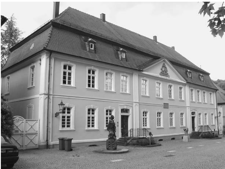
Abb. 1: Das Amtshaus in Eichersheim (heute Friedrich-Hecker-Haus)
