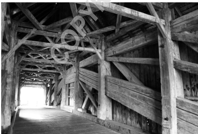
Bild 1.1 Holzbrücke des 18. Jahrhunderts (Argentringer Brücke Hiltensweiler).
