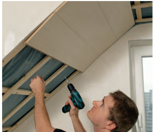
3 Paneele auf der Konterlattung befestigt
