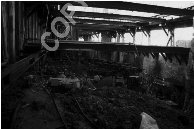
Abb. 1.1 Ausgesteifte Baugrube.
