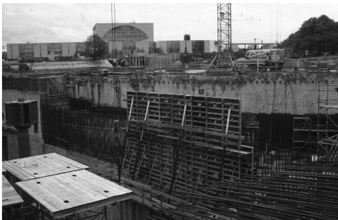
Abb. 1.2 Verankerte Baugrubenwand in Berlin.
