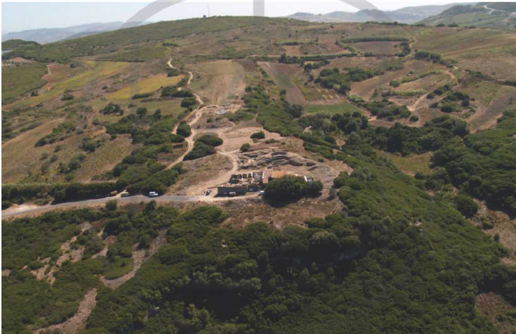
Abb. 1 Luftbild von Zambujal am 21.8.2007, Blick von Westen nach Osten auf den Bergsporn des Cabeço da Calvina, mit den kupferzeitlichen Befestigungsmauern und davor dem Bauernhaus »Casal do Zambujal«, davor der bewachsene Steilabfall in das Tal der Ribeira de Pedrulhos. Im oberen Bereich »Parafujo« sieht man noch die ehemaligen, teilweise von Hecken begrenzten Felder und auf der höchsten Stelle des Cabeço da Calvina zeichnet sich die Silhouette der ehemaligen Windmühle von Parafujo ab.
