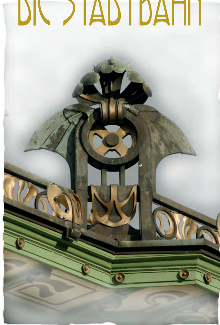
Detail der Stadtbahnstation Karlsplatz
