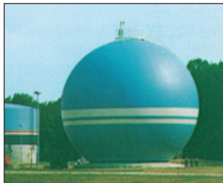
Bild 1: Flüssiggastank aus Druckbehälterstahl
