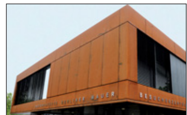
Bild 2: Fassadenplatten aus wetterfestem Baustahl
