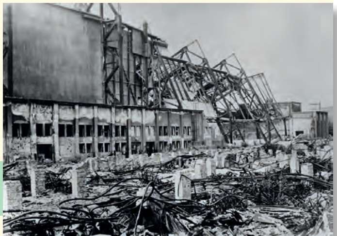
Ein zerstörtes Messegebäude in Leipzig.
