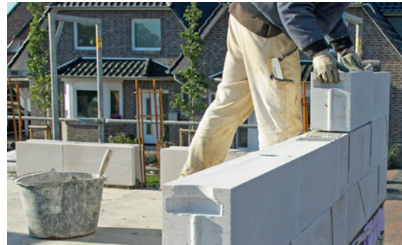
Versetzen von Porenbetonsteinen
