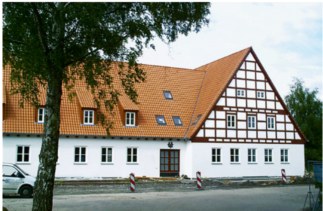
Bild 1 Umnutzung eines ehemaligen Wehrmachtsgebäudes ... in ein Pflegeheim
