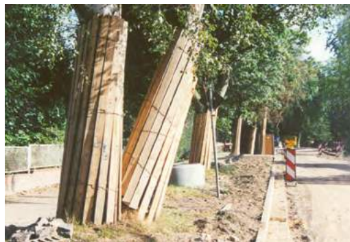
Abb. 1.15: Die Bäume werden während der Bauarbeiten geschützt.
