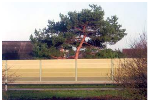
Abb. 1.13: Lärmschutzwand zwischen Wohngebiet und Bundesstraße
