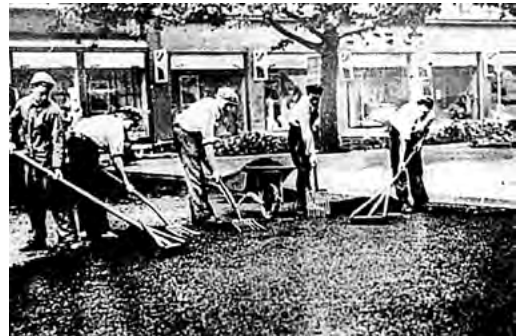
Abb. 1.7: Bau einer Teerstraße vor etwa 70 Jahren. Der Einsatz von Teer (Straßenpech) im öffentlichen Straßen- und Wegebau ist in Westdeutschland seit 1984 und in Ostdeutschland seit 1990 wegen seiner gesundheitsschädlichen Wirkung verboten.
