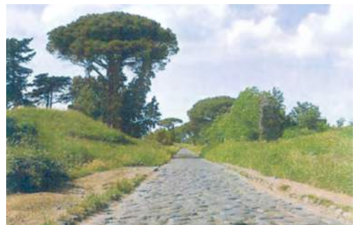
Abb. 1.2: Die Via Appia – Königin der Straßen – wurde um 300 v. Chr. gebaut und war mit Steinplatten gepflastert. Von Grabmälern gesäumt, führte sie aus Rom heraus bis nach Brindisi.
