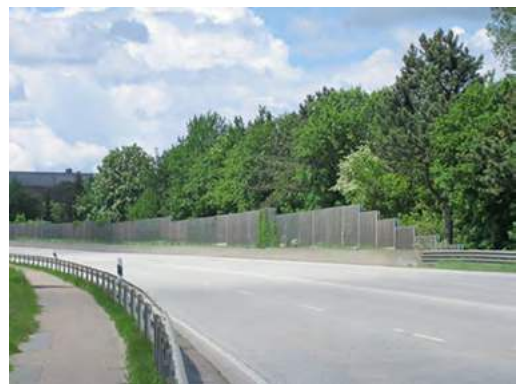
Abb. 1.8: Autostraße mit Lärmschutzwand
