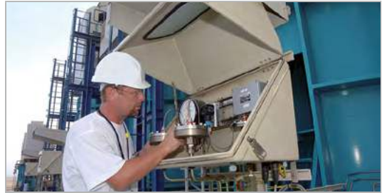
Bild 1: Prüfung einer Entsalzungsanlage von Meerwasser
