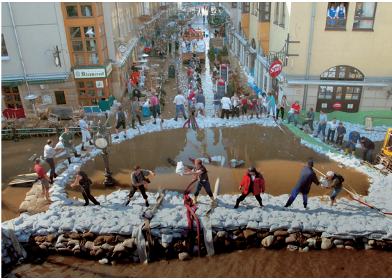
Abbildung 41: Sandsackdeich in Dresden im August 2002 (Quelle: Deutscher Depeschendienst (ddp))
