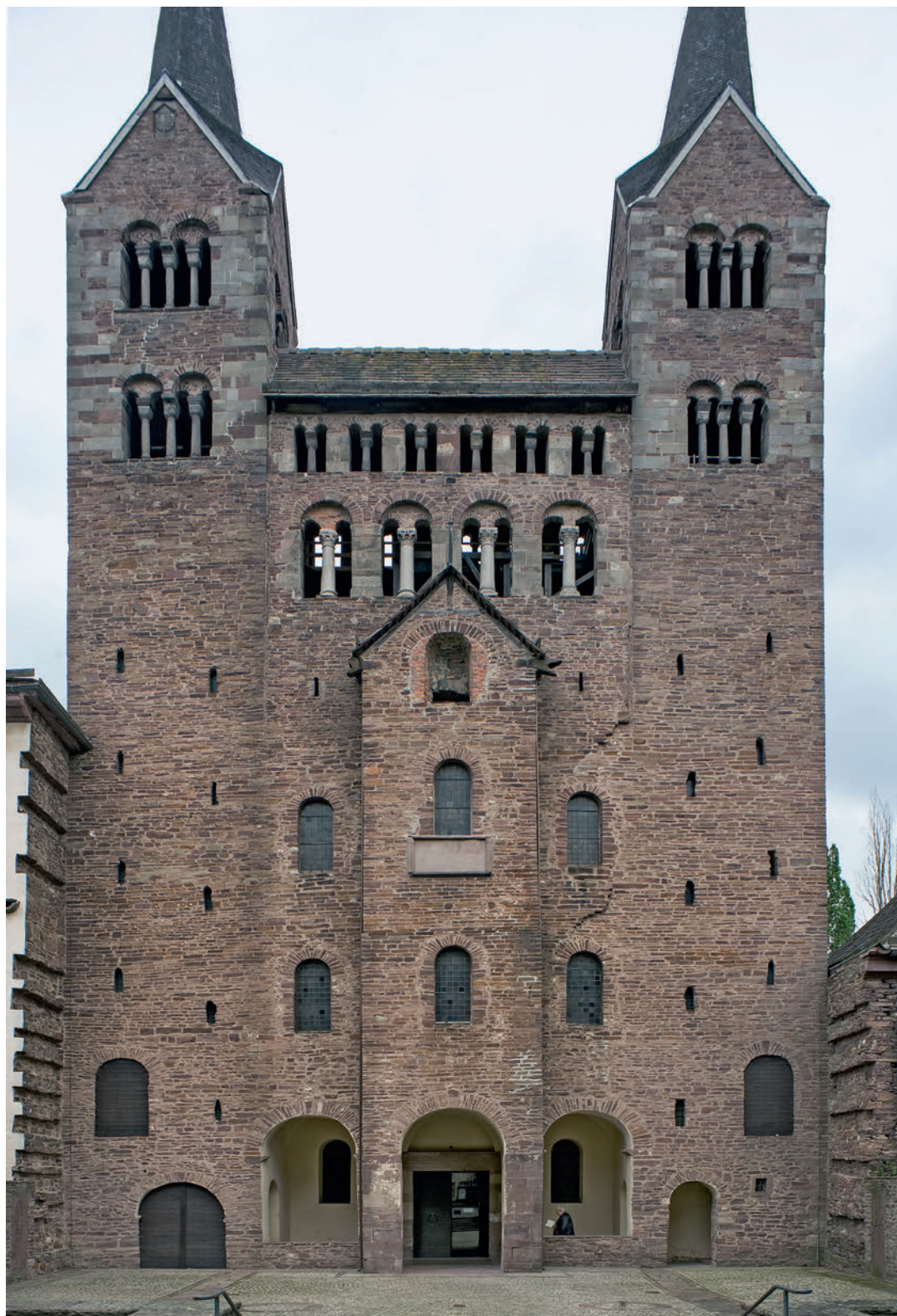
Abb. 1 Ansicht der Westfassade, 2010.
